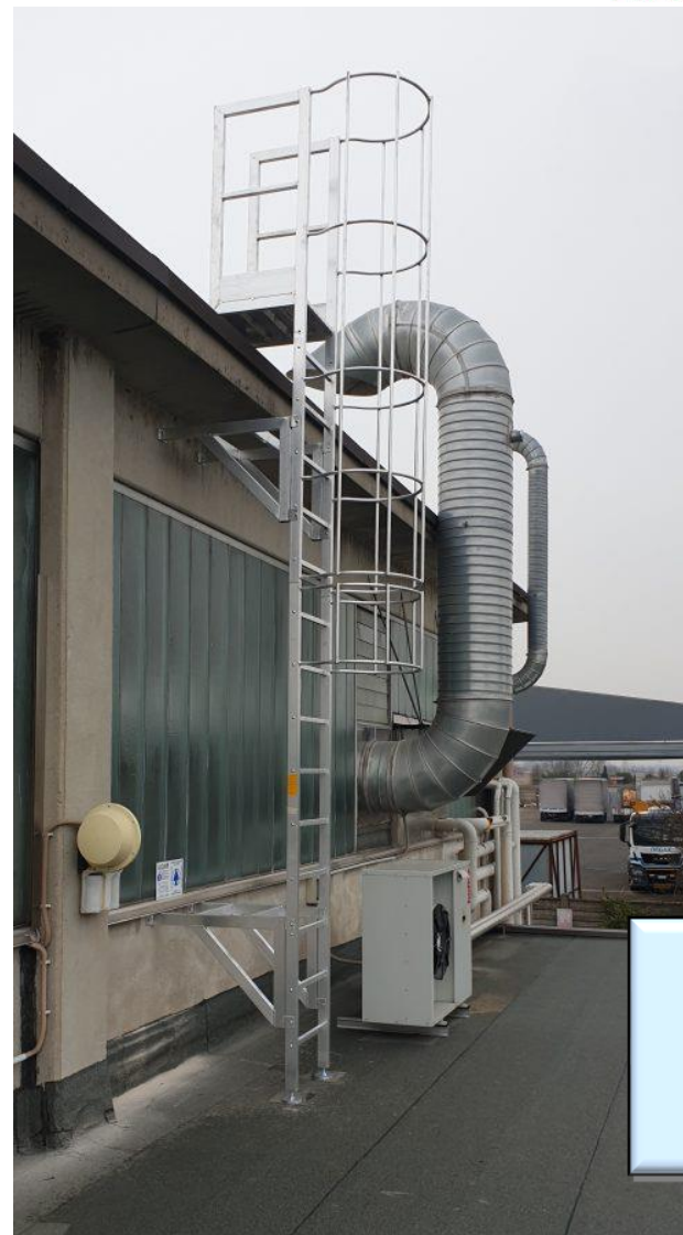
Scala di accesso a gradini con corrimano
