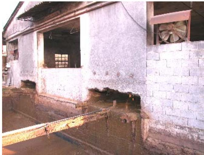
Gli eventuali cunicoli interrati, destinati ad ospitare sistemi di veicolazione delle deiezioni, devono essere dimensionati e progettati in modo da evitare intasamenti e la conseguente necessità di frequenti aperture per manutenzioni.
