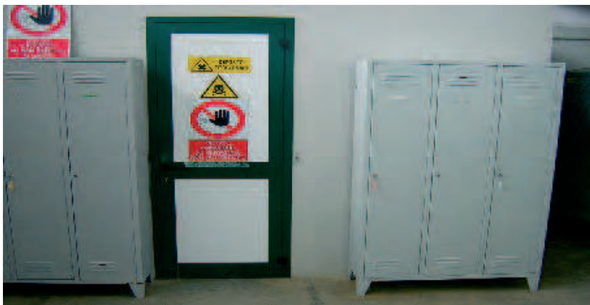
LOCALE DEPOSITO PRODOTTI FITOSANITARI CON RELATIVA SEGNALETICA DI SICUREZZA
