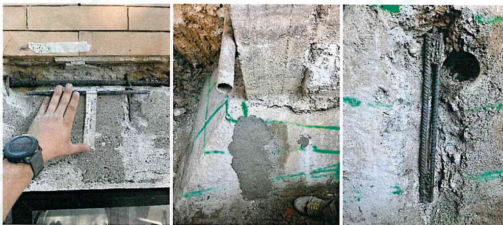
Foto: esempio di prelievo e ripristini campioni in acciaio
