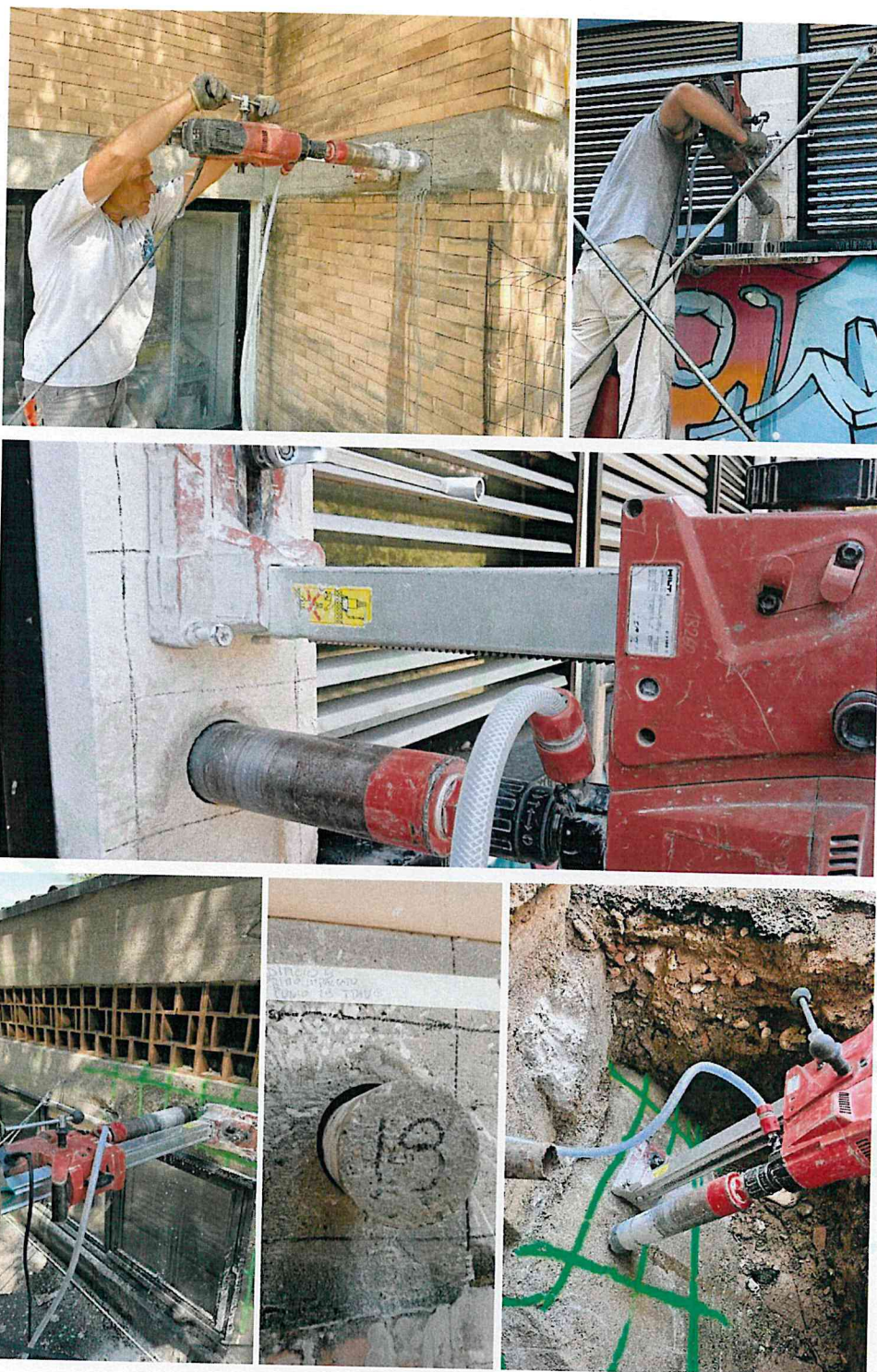
Foto: esempi di prelievo campioni attraverso carotaggio
